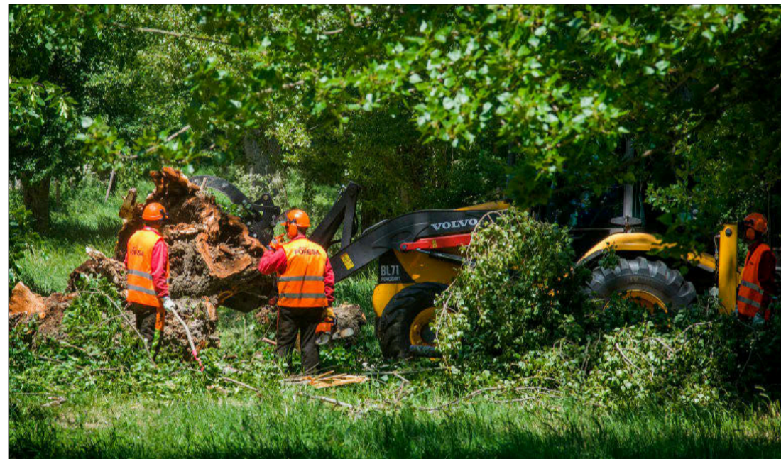
Los operarios trabajando en el apeo de uno de los árboles del parque de El Parral. TOMÁS ALONSO
