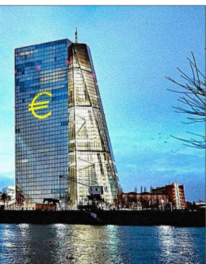
Edificio en Fráncfort, Alemania, del BCE. EM
